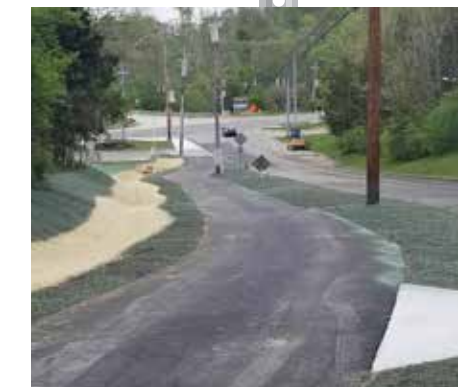
Elstun Avenue sidewalk
